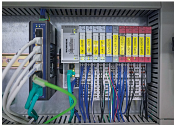
Die zentrale BL20-I/O-Station sitzt an der Zentralschmieranlage und gibt alle Signale über Profinet an das HMI TX513 weiter
